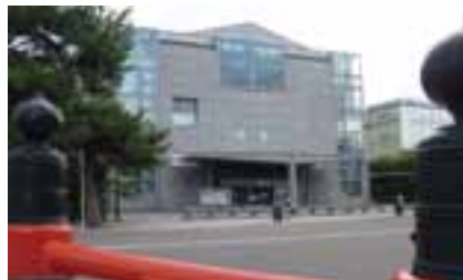
京都国立近代美術館 新館（1986年竣工）
