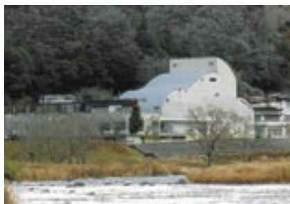
「やまなみホール」と傍らを走るJR関西本線の車輪
