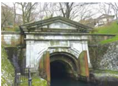
第一トンネル東口
