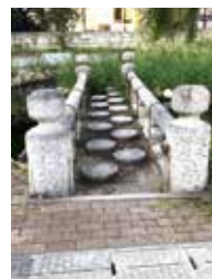
伏水街道第一橋
